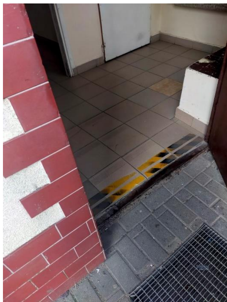
Zdjęcie nr 7: Wejście do Budynku I
