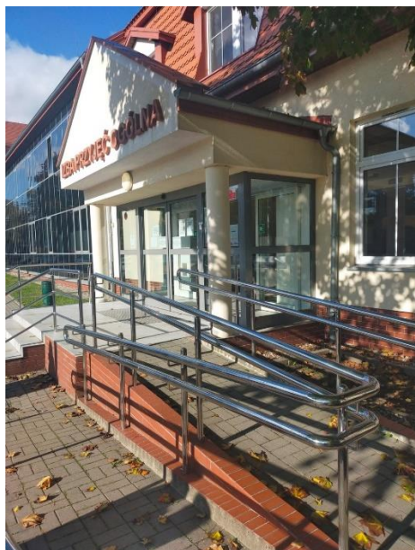
Zdjęcie nr 4: Pochylnia zewnętrzna
